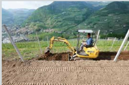
essere trasportati nel vigneto (funi, pali, ganci di ancoraggio, ecc.). In base alla ruspa utilizzata, la struttura portante può essere montata anche prima del terrazzamento. Il nuovo impianto può quindi essere inerbito, per rendere il suolo più stabile e prevenirne l’erosione.
